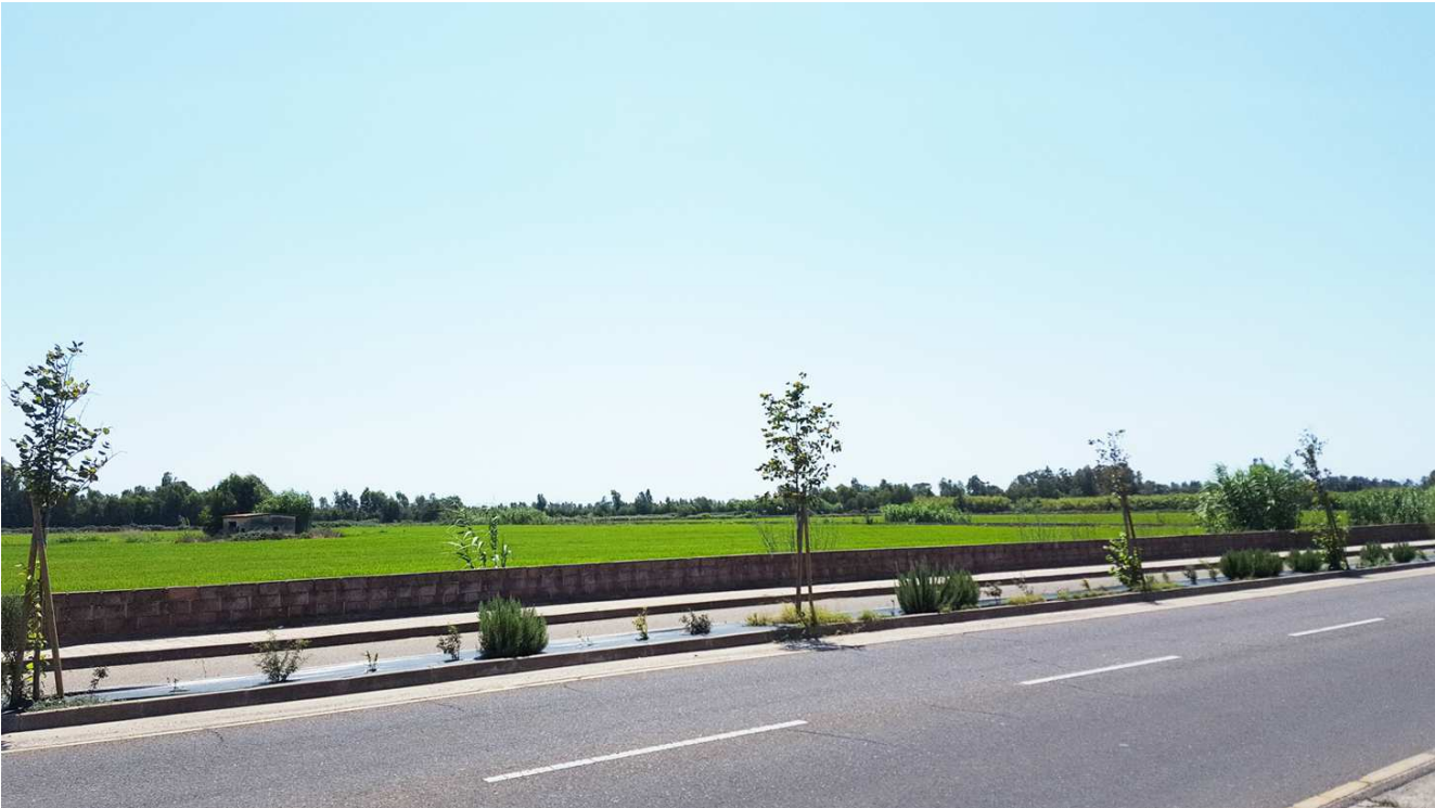
vista lato est
